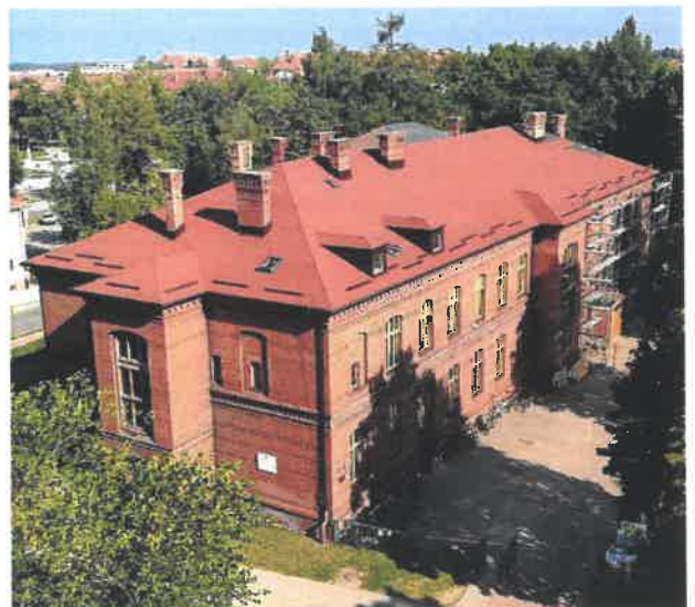
Remont dachu I Liceum Ogólnokształcącego
